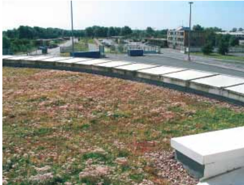
Angenehmes arbeiten im Neustädter Hafen. Die Mitarbeiter der Bremer Lagerhaus Gesellschaft und die Zech Industriebau profitieren vom Bremer Förderprogramm für extensive Dachbegrünung.
