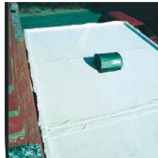
Folien werden durch ein Schutzvlies vor Beschädigungen geschützt.
