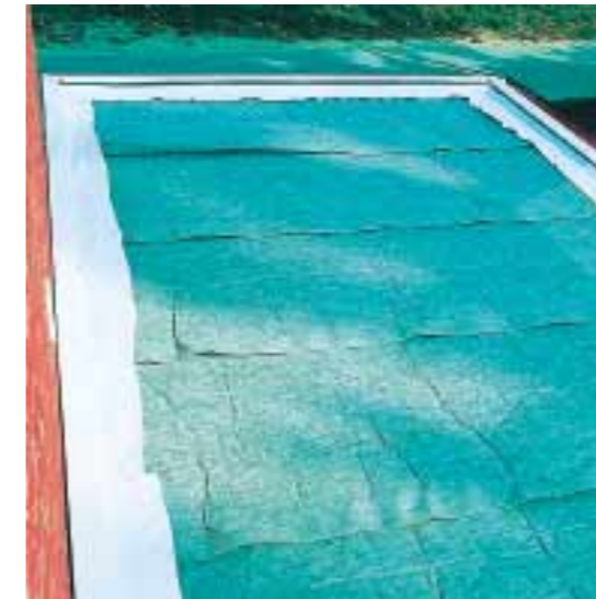
Auf die mit Vlies abgedeckte Dränageschicht kann jetzt das Substrat aufgebracht werden.
