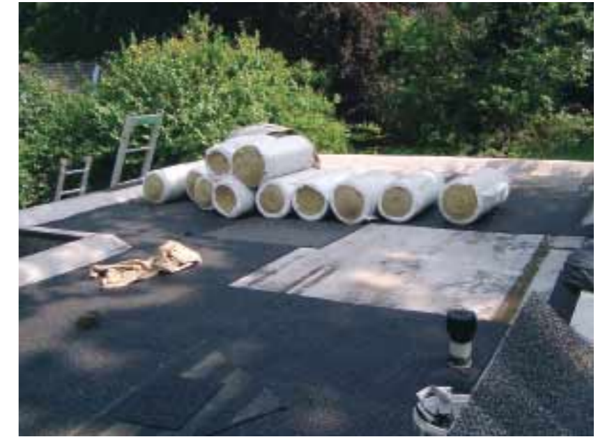
Mineralwollplatten als Vegetationstrage- und Filterschicht kurz vor dem Verlegen auf einem Flachdach in Bremen Oberneuland. (Gefördert durch das Bremer Förderprogramm)
