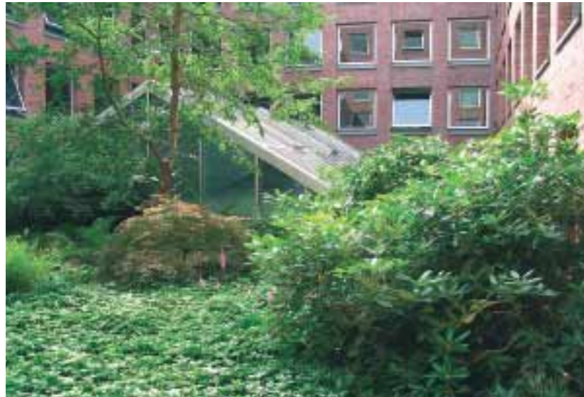
Intensiv begrüntes Dach im World Trade Center Bremen. Viermal im Jahr kommt der Gärtner.
