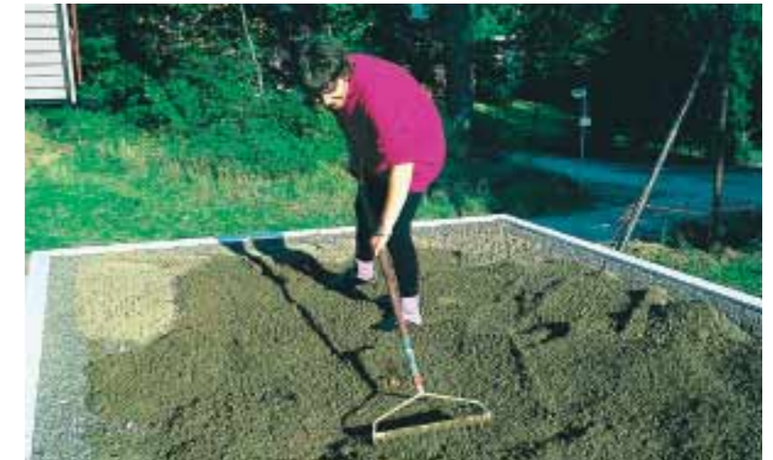
Die Substratmischung wird mit einer Harke gleichmäßig verteilt.
