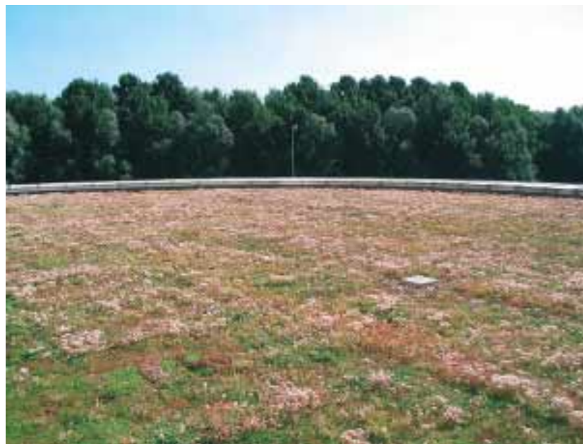
Viele Flachdächer lassen sich nach Entfernung der Kiesschicht begrünen, wie hier im Neustädter Hafen.
