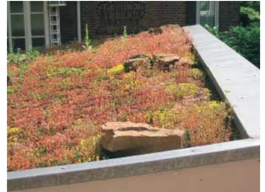
Ein vom Bremer Senator für Bau, Umwelt und Verkehr gefördertes Garagendach in Schwachhausen.
